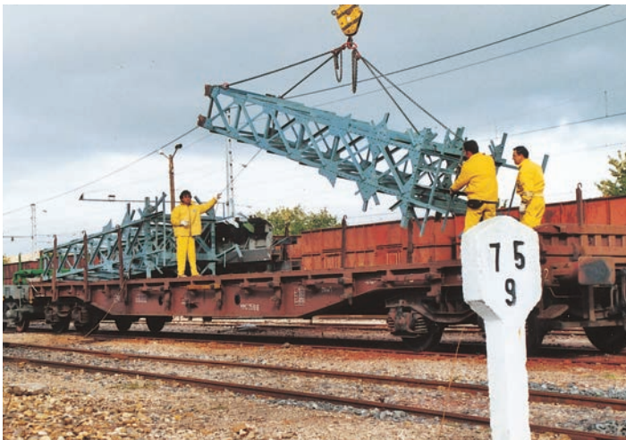
Carga del puente de señales para su traslado a Madrid.
