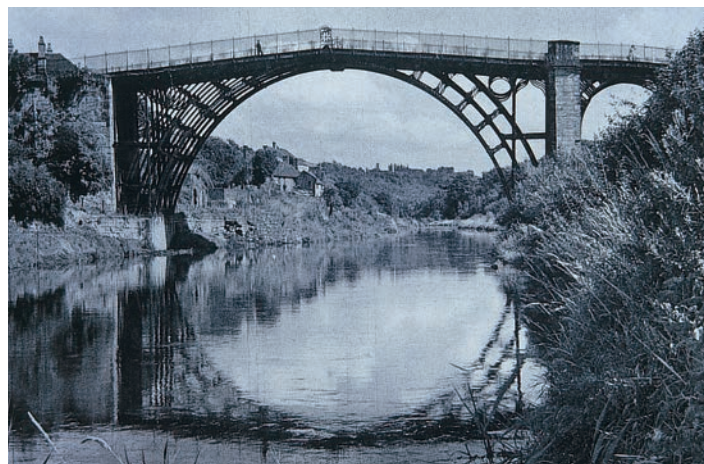
Puente sobre el Severn en Coalbrookdale.
