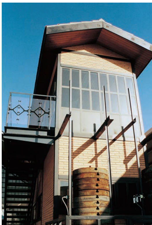
Detalle de la caseta, terminada la obra.
