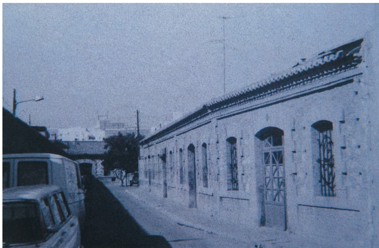
Grupo Ramón de Castro. Sociedad Constructora de casas para obreros de Valencia, 1906.
