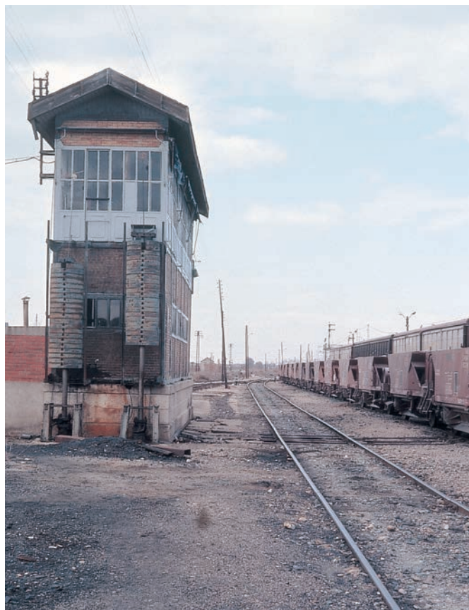
Caseta de enclavamiento en la estación de Algodor en 1999.
