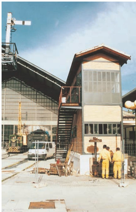
Montaje de contrapesos en la nueva caseta en febrero de 2003.
