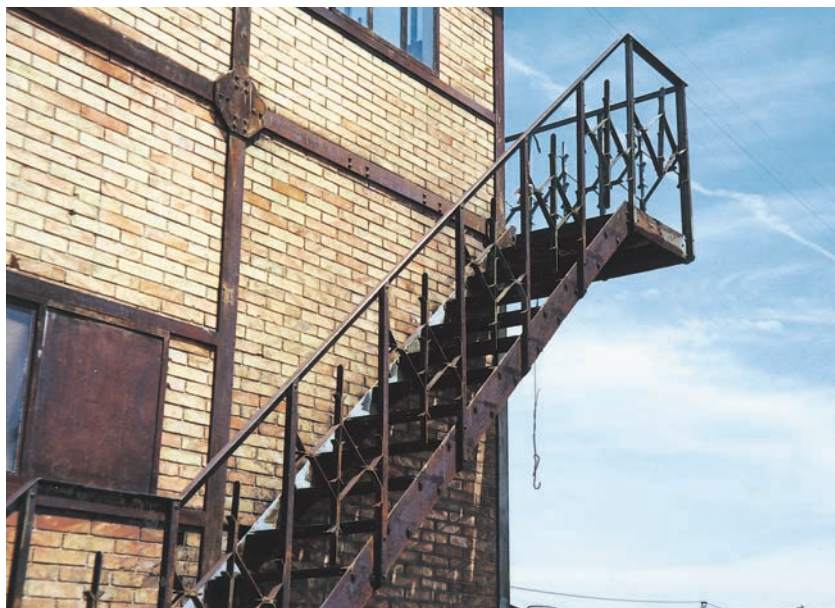
Escalera en la caseta original.
