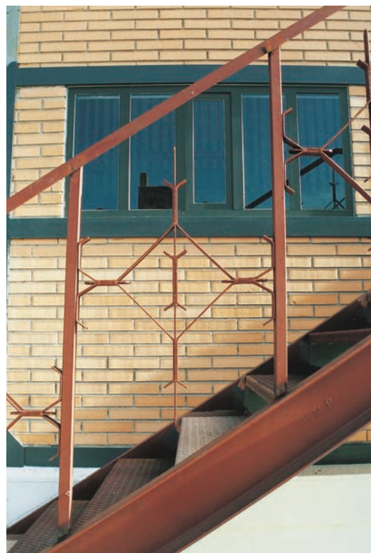
Detalle de la barandilla de la nueva escalera.
