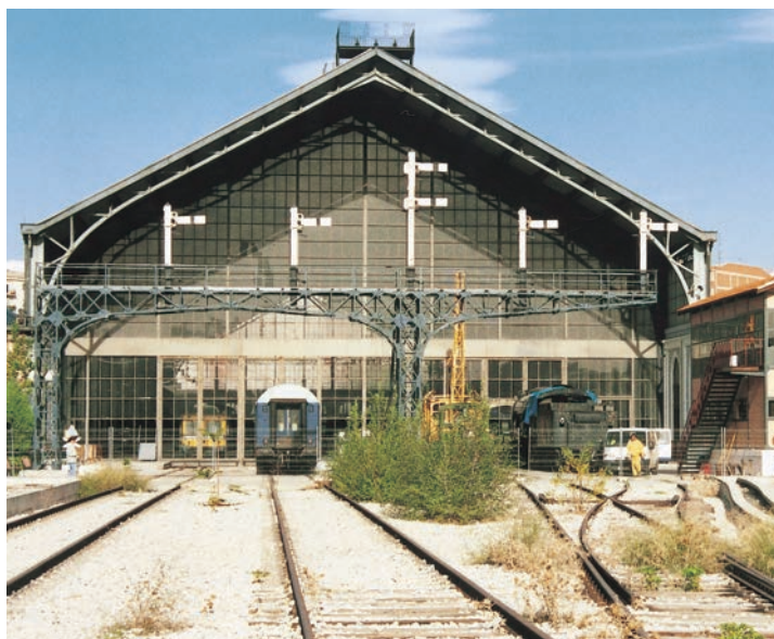
Puente de señales ya instalado en el Museo.
