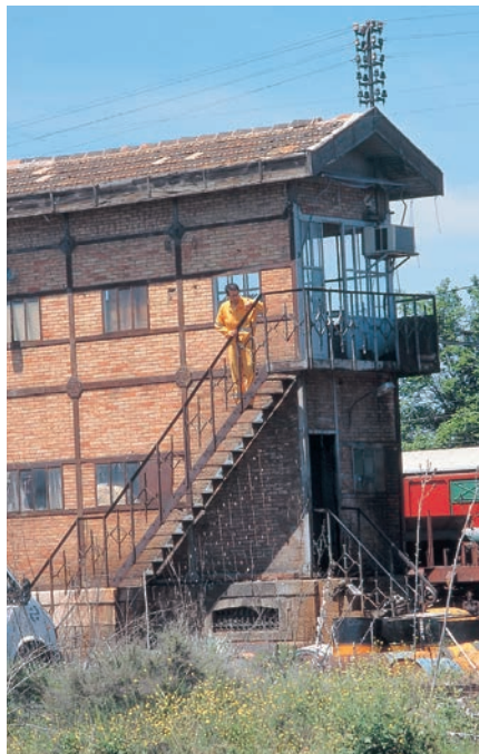
Vista en la caseta original en Algodor, década de 1990.
