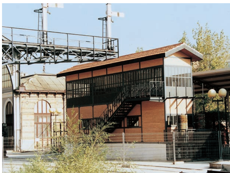
Puente de señales y caseta en el Museo de Madrid, en septiembre de 2003.
