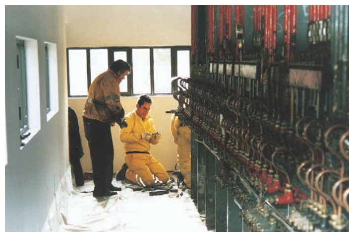
Conexión de tuberías en el aparato central del enclavamiento, durante 2003.
