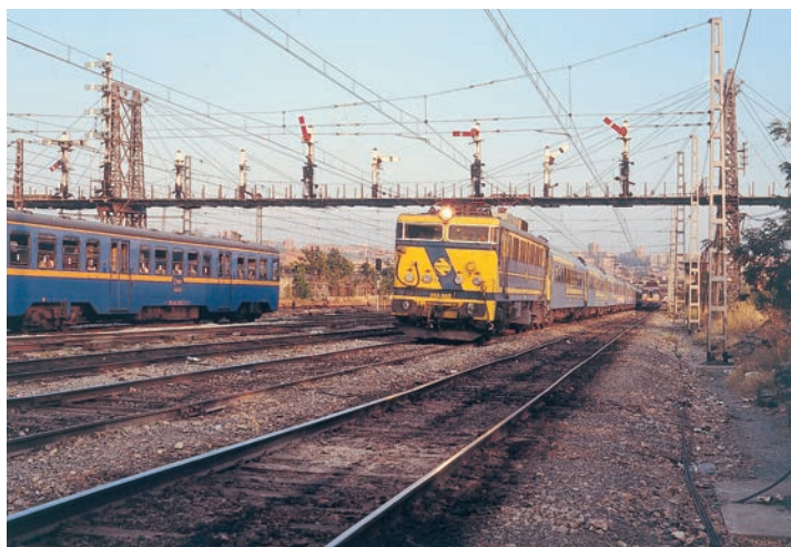
Puente de señales del Puesto B del enclavamiento hidráulico de Madrid - Atocha en 1988.
